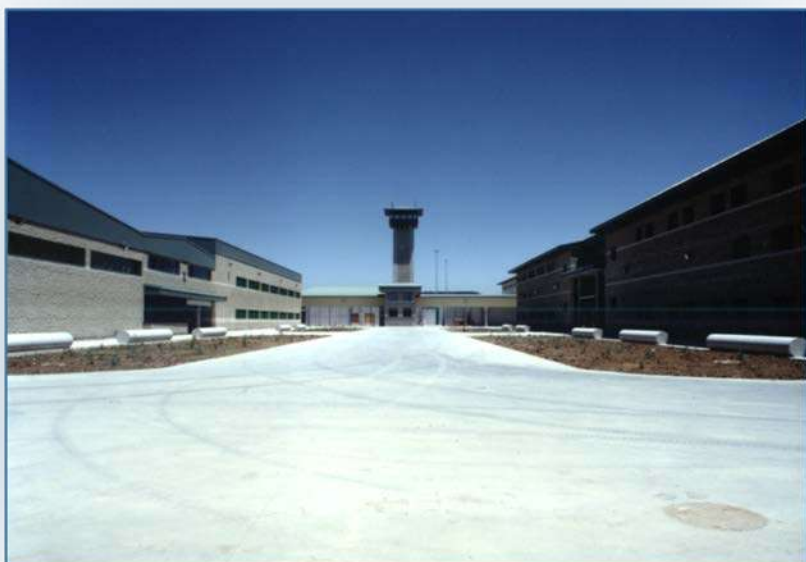
Centro penitenciario Córdoba
