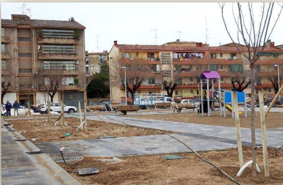
Trabajos de urbanización en la parcela de la antigua cárcel provincial de Huesca
