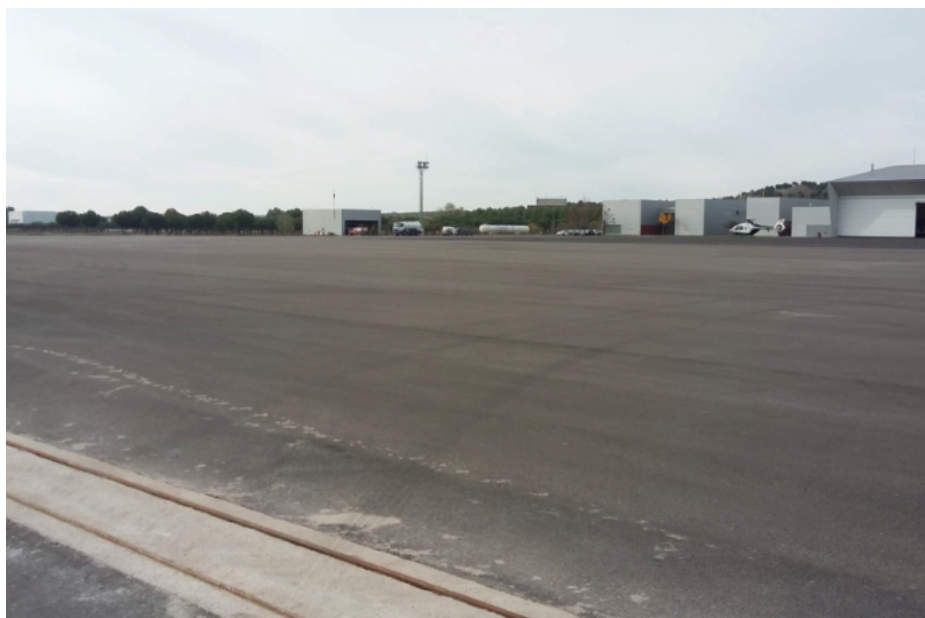
Calle de rodaje en la Base Aérea de Torrejón de Ardoz
