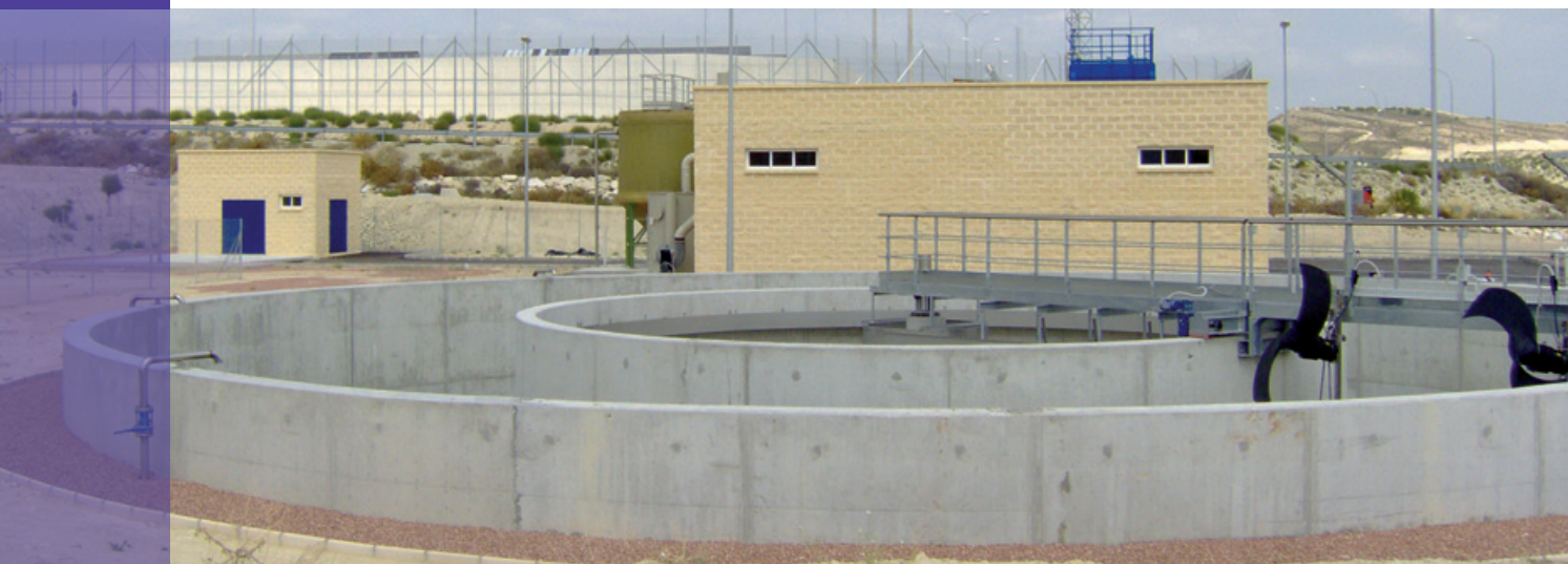
EDAR centro penitenciario
