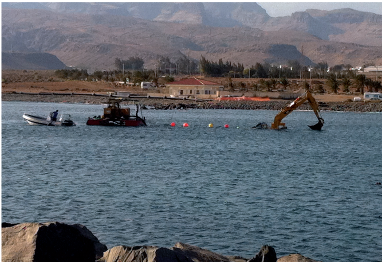
Obras emisario submarino CP Las Palmas II
